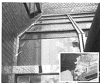
写真2 指定間隔で枠回りの止水注入(矢印)および樹脂注入口(右下)
