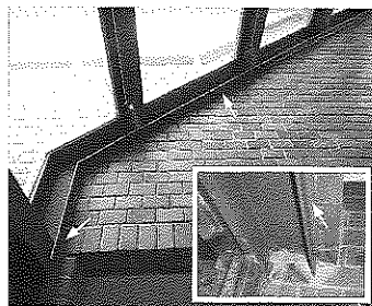
写真1 水が噴き出る鉄骨フレーム壁際および柱脚(右下)
