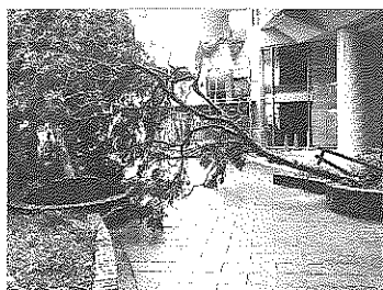
写真1 台風により倒れたポット型単独植込の樹木
