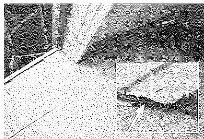
写真3 小屋裏とつながる軒のふところの水抜き隙間
