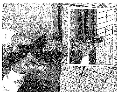
写真3 サッシ抱きのサンダーカットは傷つけ事故が多い
