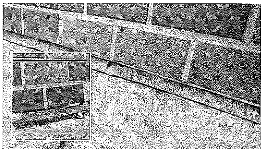
写真4 防水末端処理のため躯体に切り込みを入れたところ(矢印)
