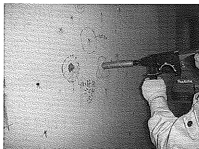
写真-4 コア抜きしてモルタル層厚確認
