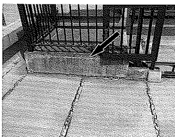
写真-14 防水層の上に施工された構築物
