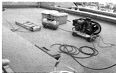
写真1 防水層上に直接置かれた工具や機材
