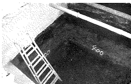
写真1 地下室築造で1階床下を3mほど掘削しようとした事例
