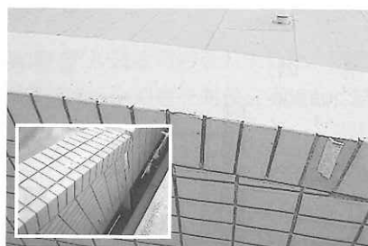
写真1 タイル張りの上に塗膜防水した腰壁天端の状態 (左下は防水塗布前の天端)
