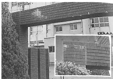
写真1 エフロレッセンスの出方が特徴的な門柱天端付近
