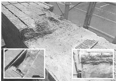
写真2 タイル割つけでかさ上げし、水を蓄えた厚いバサモルタル
