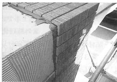
写真3 バサモルタルを撤去してタイルを割つけし直し、有機系接着剤で復旧
