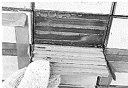
写真2 新築施工時点の接着モルタルの詰まり不全 (躯体との接着は良好)
