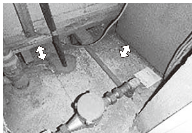
写真1 住戸床下とつながっている木軸区画のメーターボックス
