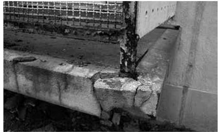
写真2 埋込型鉄製支柱基部の腐食による膨張圧での破損
