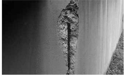
写真1 中性化が進みやすい出隅部の欠損による露筋
