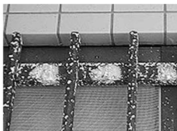
写真3 縦横と横横の入隅は、空気よどみができ、中央部の点蝕が激しくなる
